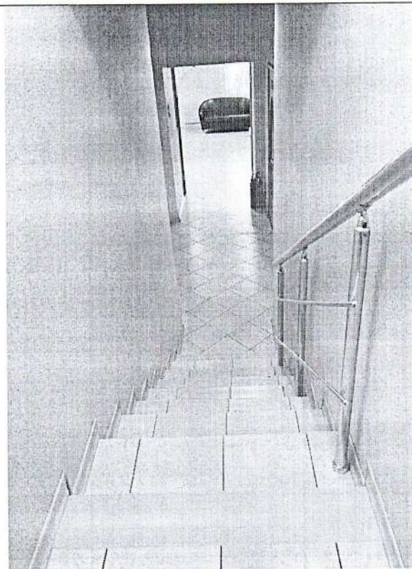
Фото №10 «Лестница внутри здания»
